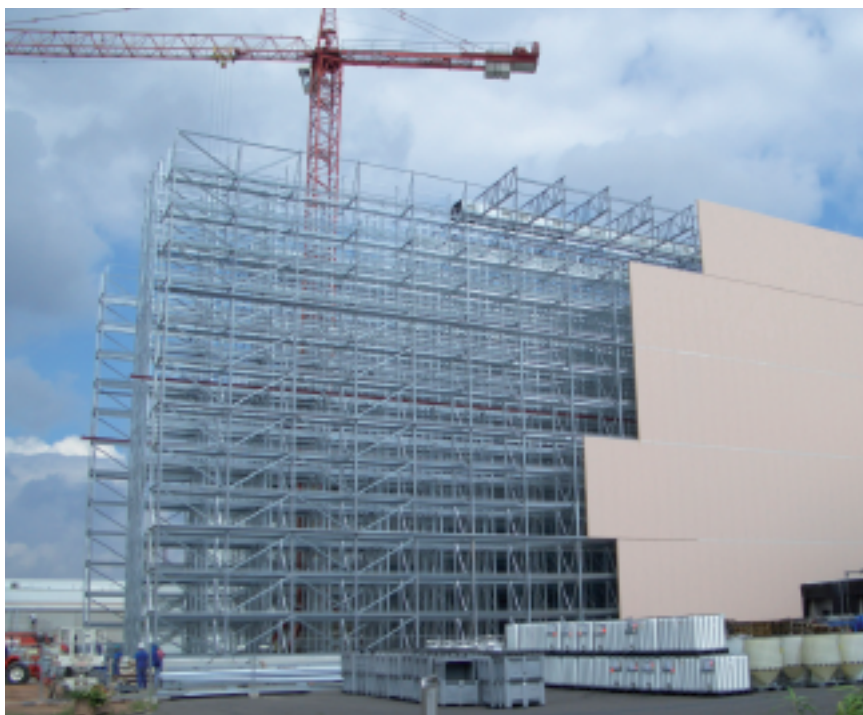
Traggerüst sinnvoll wählen: Mal ist eine Silobauweise sinnvoll, bei der das Regal die Wände und Dächer trägt, mal eine getrennte Stahlkonstruktion, in der die Regale im Nachgang aufgestellt werden.
