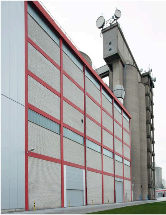
Bild 6: Bestehendes Werksgebäude in Skelettbauweise
