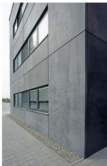
Bild 12: Anthrazit gefärbte Fassadenelemente im vorderen Gebäudebereich
