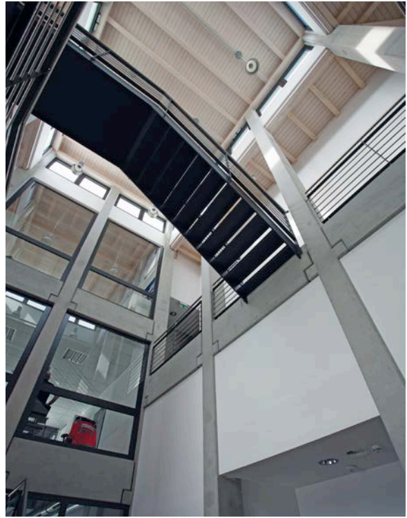
Bild 7: Aufragende Betonstützen im Lichthof
