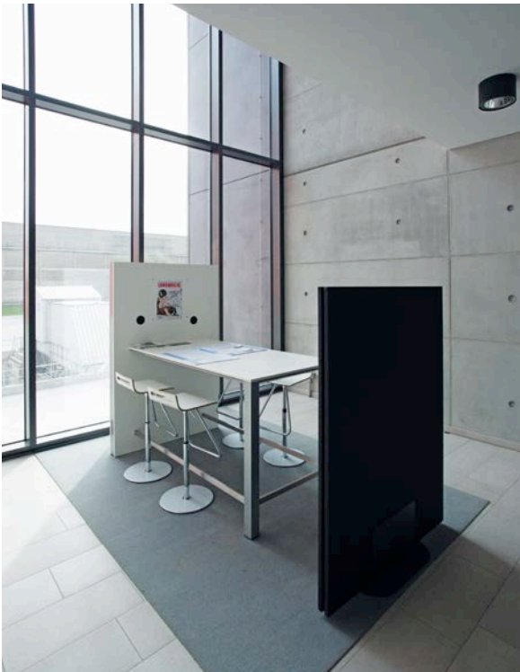
Bild 8: Offener Kommunikationsbereich mit Sichtbeton in Ortbetonbauweise
